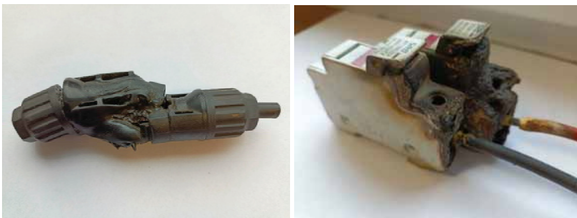
Rys. 1. Skutki nieprawidłowego połączenie złączek i zacisków roboczych podstaw bezpiecznikowych
